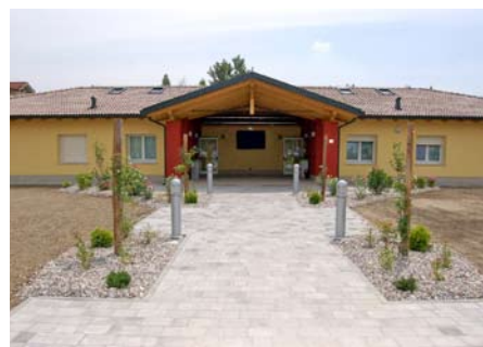
Rovereto: Centro Servizi Polifunzionale - Costruito ex novo
