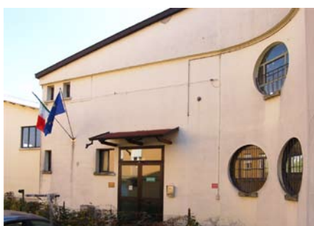
S. Antonio: Bocciodromo piano terra - Ripristinato
