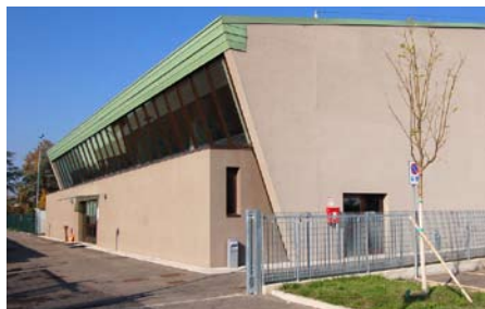
Novi: Palestra comunale "M. Franciosi" - Terminata dopo il sisma
